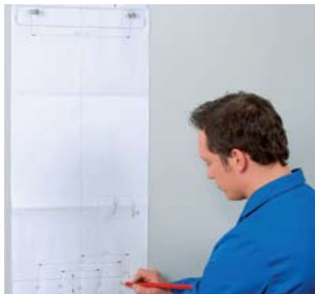
1. Предварительная разметка с помощью монтажного шаблона
