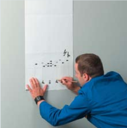
1. Используйте специальный шаблон для монтажа
