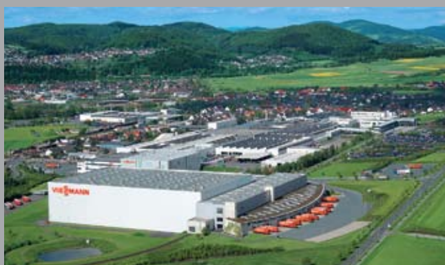
Завод Viessmann в г. Аллендорф / Германия
