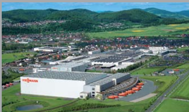
Завод Viessmann в г. Аллендорф / Германия
