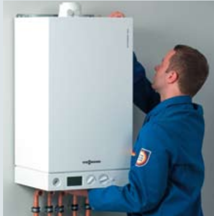
2. Закрепите котел на стене
